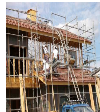
木造住宅新築
