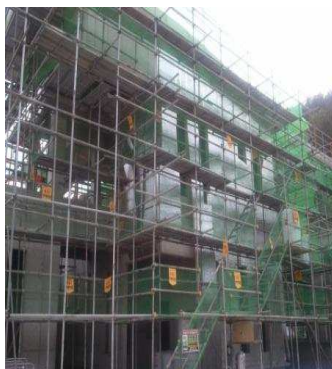
下水処理場増築
