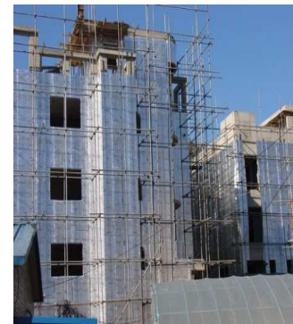
低層マンション新築
