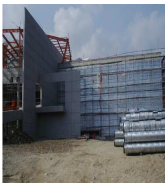
水力発電所増築
