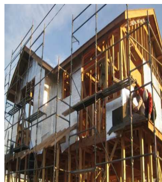
木造住宅新築
