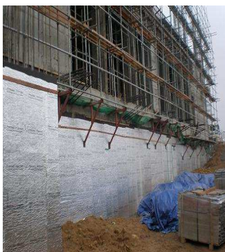
物流倉庫新築
