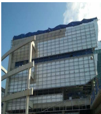
火力発電所増築
