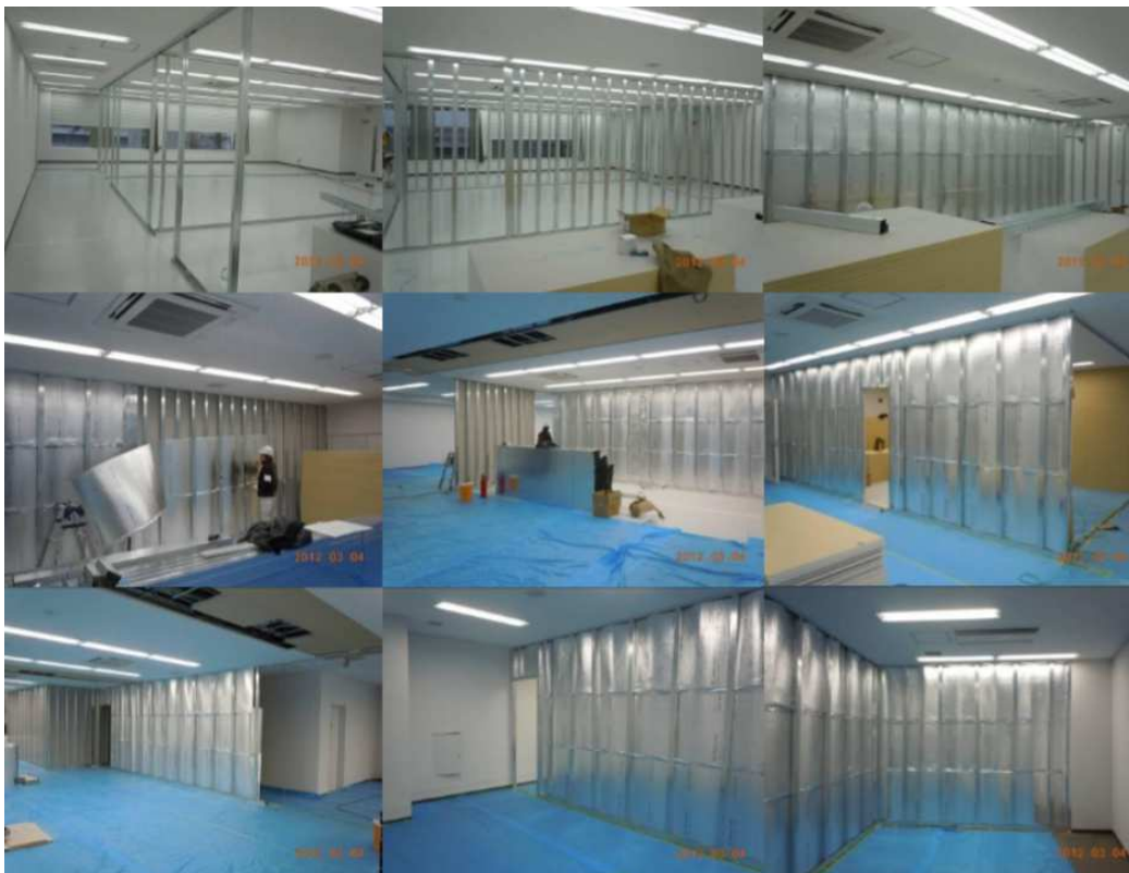
某大手都市銀行断熱工事
