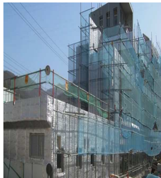
スポーツセンター新築
