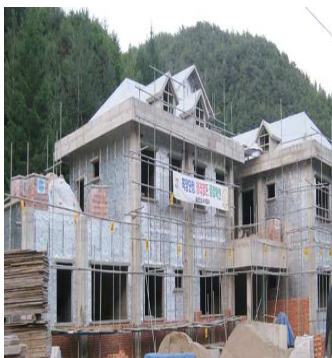
養護施設新築
