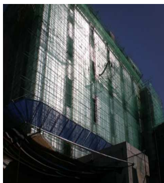
冷凍倉庫新築
