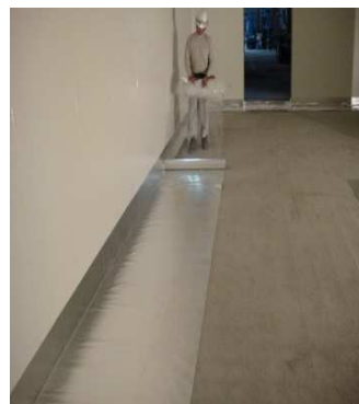
冷凍倉庫 (壁、床、天井)
