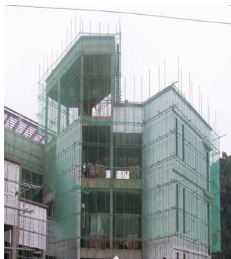
製薬工場増築
