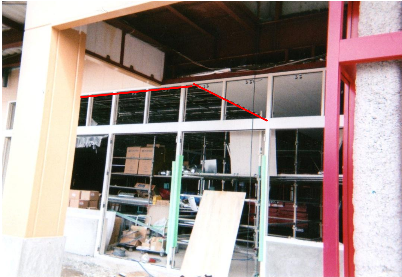
新築GMSの断熱対策、天井部結露、防カビ対策:プライムJP6を全面施工
